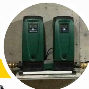
Offre prestazioni eccezionali grazie alla possibilità di funzionamento combinato, con ingombri ridotti del 50% rispetto a qualsiasi altro sistema tradizionale equivalente. e.sytwin permette di sfruttare a pieno le potenzialità di e.sybox nella realizzazione di gruppi a due pompe.
